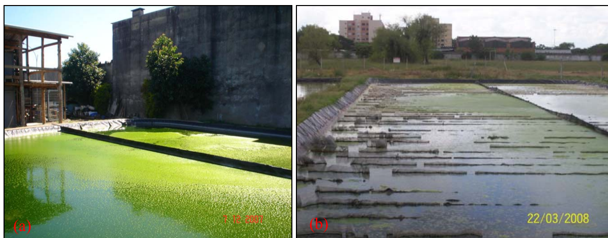
Figura 1. Lagoas de polimento utilizadas no estudo: (a) convencional; (b) com biofilme
